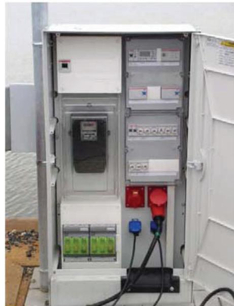
Bild oben: Stromtankstelle mit integrierter Abrechnungseinheit
