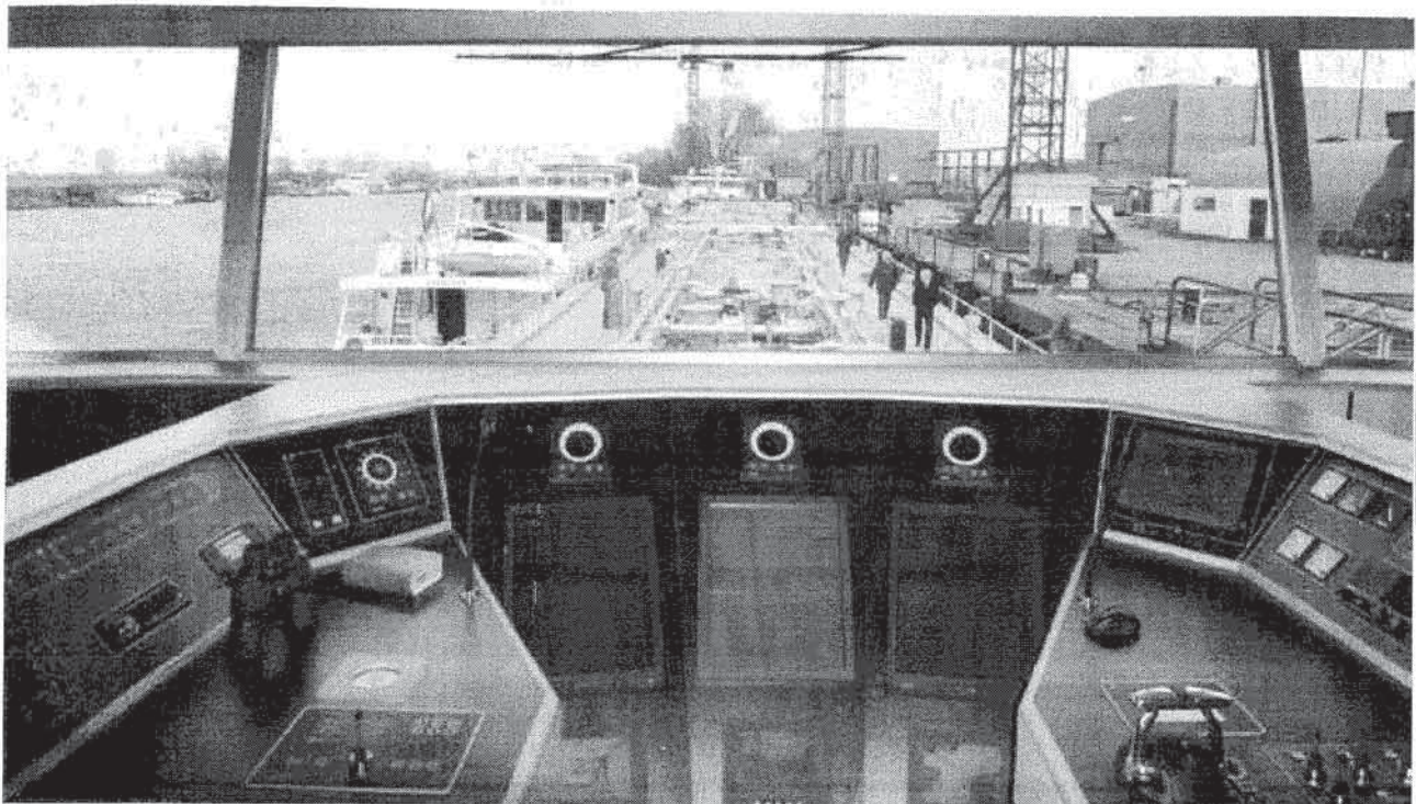
Die Steuerhäuser auf modernen Binnenschiffen verfügen über jede Menge elektronischer Anzeigen und Geräte, die dem Schiffsführer während der Fahrt ständig aktuelle Daten liefern
